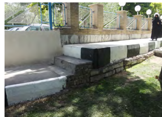
۲۱۵۹ - پیاده‌روسازی مقابل ساختمان شهرداری مرکزی
